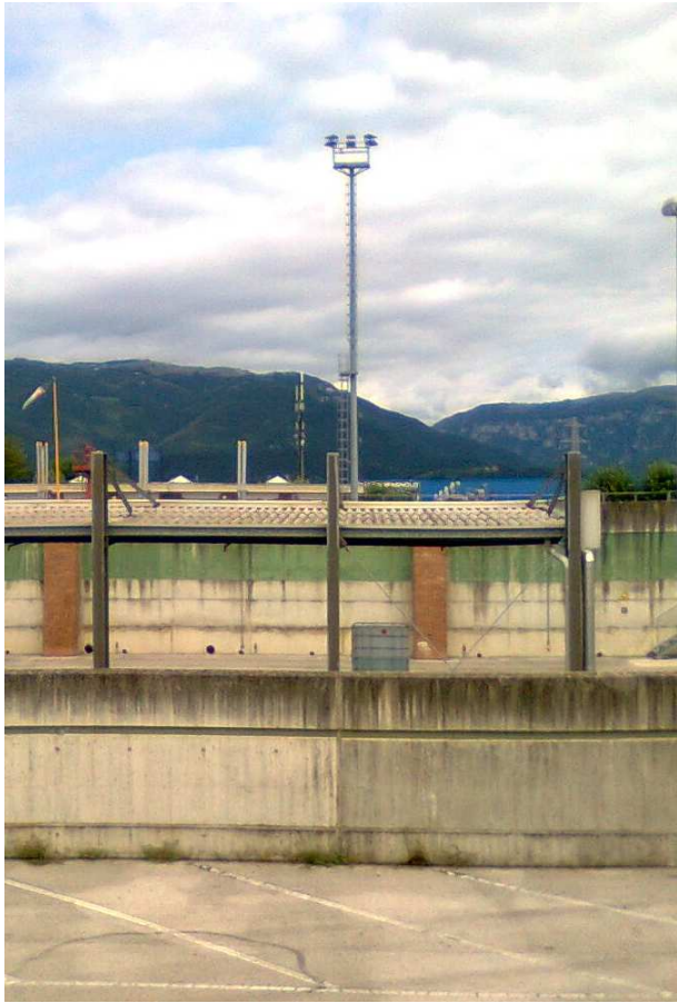
Figura 1 – Foto dell'impianto SRB visto dalla postazione di misura della centralina.
